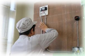
(電気工事部門)
